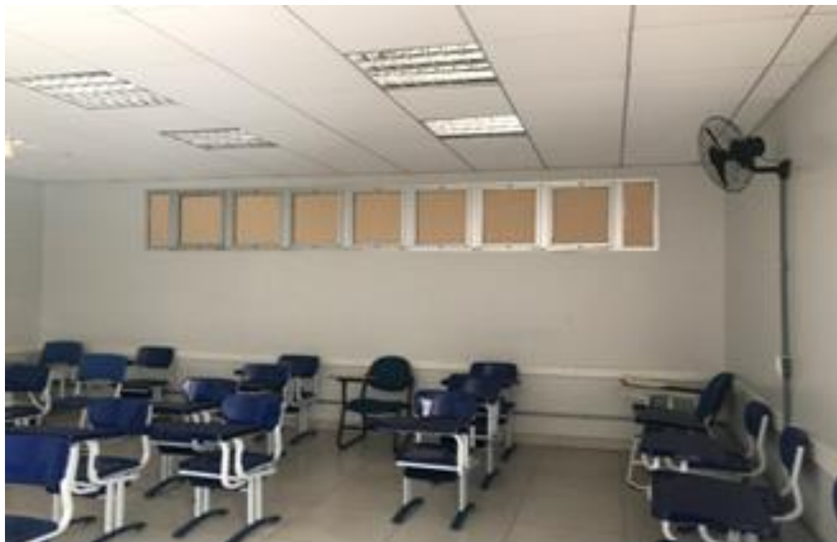
Figura 2 – Foto interna de sala de aulas, na Faculdade UnB Planaltina, evidenciando a necessidade de avaliação técnica das janelas quanto às suas características de ventilação.
