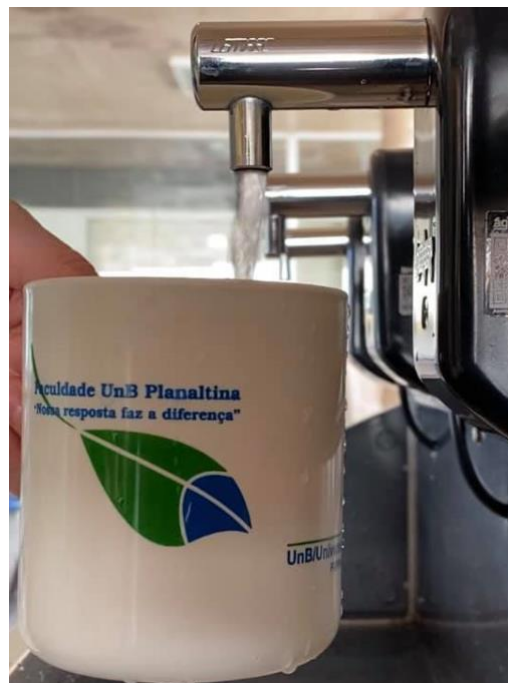
Figura 4 - Torneira com acionamento por sensor em bebedouro
