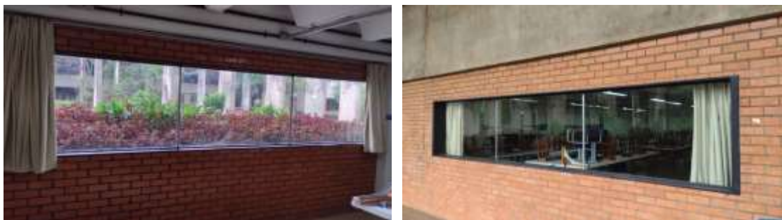
Figura 2 – Vista interna e externa da janela do Laboratório de Física 2. As janelas estão voltadas para o corredor do ICC. Estas janelas não abrem.
